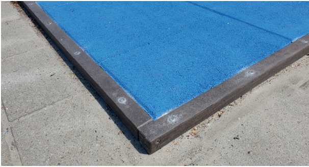
Rubber tegels rechtstreeks op de bestaande verharding afgewerkt met een afgeronde kunststof boord.
