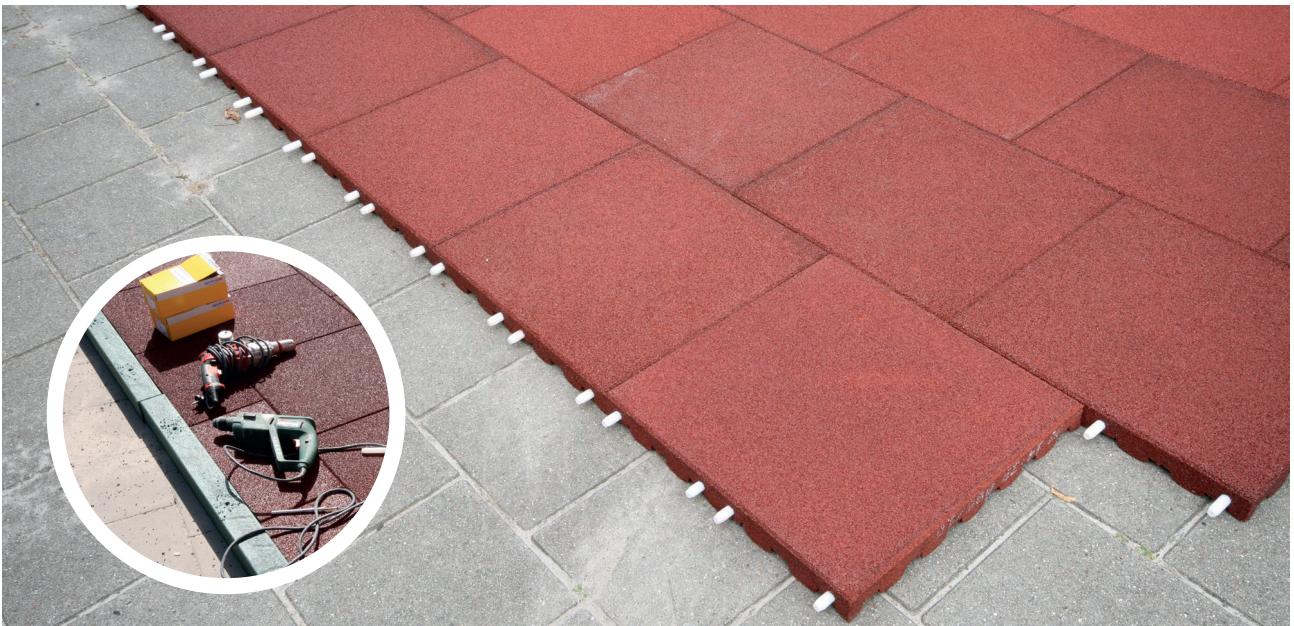
Rubber tegels verzonken t.o.v. bestaande verharding: beter resultaat, maar ingrijpende werken. De bestaande verharding verwijderen en een bed van stabilisé of aan gedrield steenpuin voorzien.
