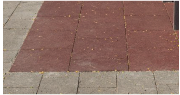
Rubber tegels verzonken t.o.v. bestaande verharding: beter resultaat, maar ingrijpende werken. De bestaande verharding verwijderen en een bed van stabilisé of aan gedrield steenpuin voorzien.
