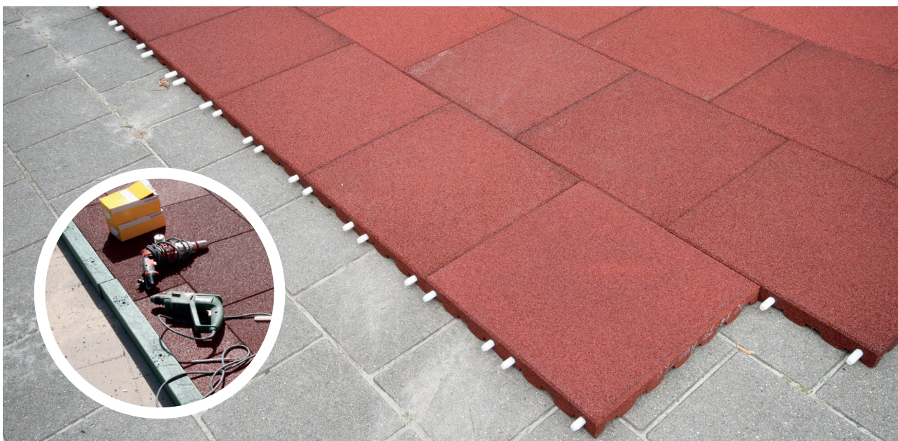
Dalles en caoutchouc encastrées par rapport au revêtement existant : Meilleur résultat, mais travaux plus importants. Retrait du revêtement existant et réalisation d'un lit de stabilisé ou de concassé compacté.
