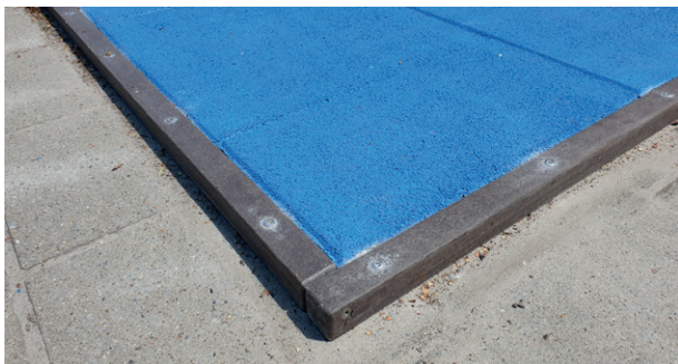
Dalles caoutchouc installées sur un sol dur avec bords arrondis.
