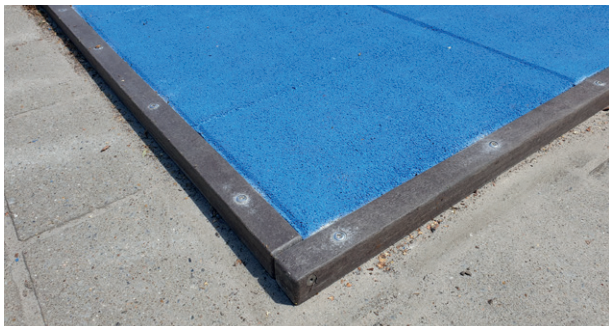
Dalles en caoutchouc posées directement sur le revêtement existant, avec une finition assurée par une bordure arrondie en matière synthétique
