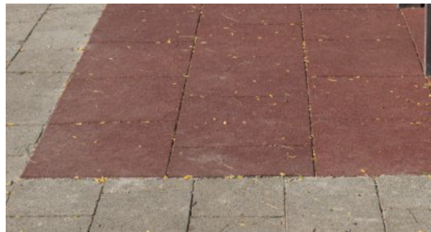
Les dalles en caoutchouc encastrées par rapport au revêtement existant apportent un résultat plus esthétique, mais nécessitant des travaux plus importants. Le revêtement existant doit être retiré et remplacé par une couche de fondation en stabilisé ou en concassé compacté.
