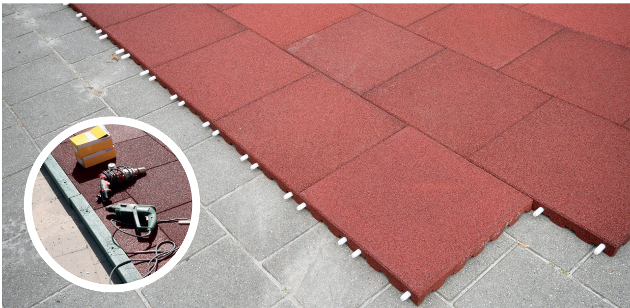
Les dalles en caoutchouc encastrées par rapport au revêtement existant apportent un résultat plus esthétique, mais nécessitant des travaux plus importants. Le revêtement existant doit être retiré et remplacé par une couche de fondation en stabilisé ou en concassé compacté.
