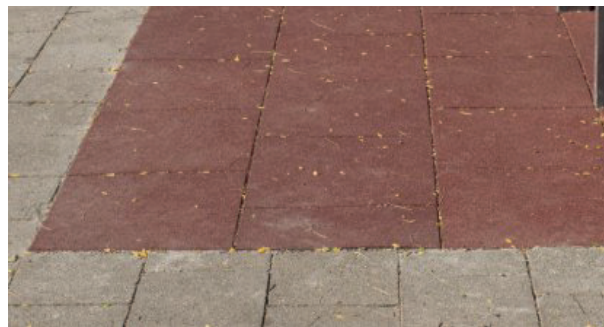
Dalles en caoutchouc encastrées par rapport au revêtement existant : Meilleur résultat, mais travaux plus importants. Retrait du revêtement existant et réalisation d'un lit de stabilisé ou de concassé compacté.
