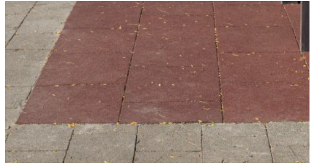
Rubber tegels verzonken t.o.v. bestaande verharding: beter resultaat, maar ingrijpende werken. De bestaande verharding verwijderen en een bed van stabilisatie of aangetilde steenslag voorzien.
