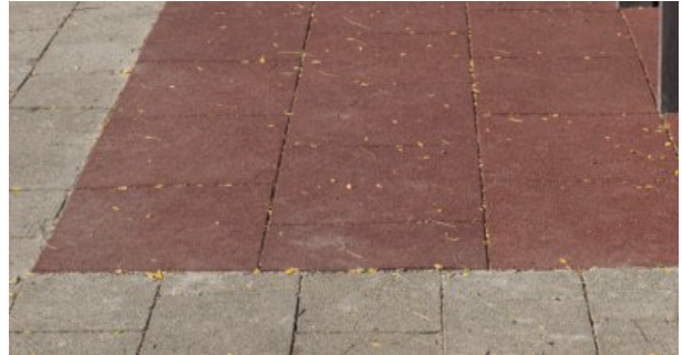
Rubber tegels verzonken t.o.v. bestaande verharding: beter resultaat, maar ingrijpende werken. De bestaande verharding verwijderen en een bed van stabilisé of aan gedrild steenpuin voorzien.
