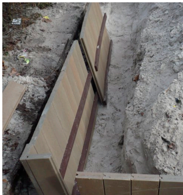
Détail de placement des planches de renfort
