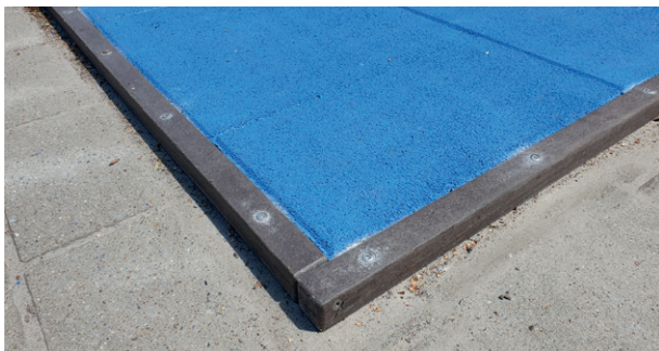
Rubber tegels rechtstreeks op de bestaande verharding afgewerkt met een afgeronde kunststof boord.
