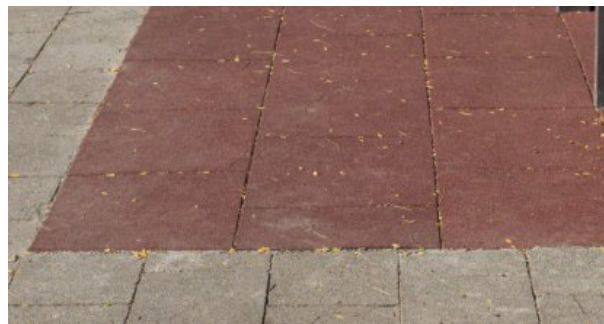
Rubber tegels verzonken t.o.v. bestaande verharding: beter resultaat, maar ingrijpende werken. De bestaande verharding verwijderen en een bed van stabilisé of aan gedrild steenpuin voorzien.
